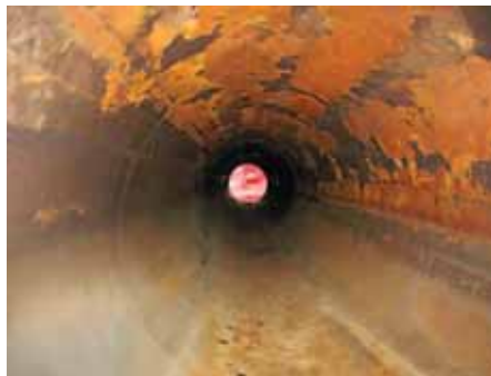
Korroosiota putkistossa.
