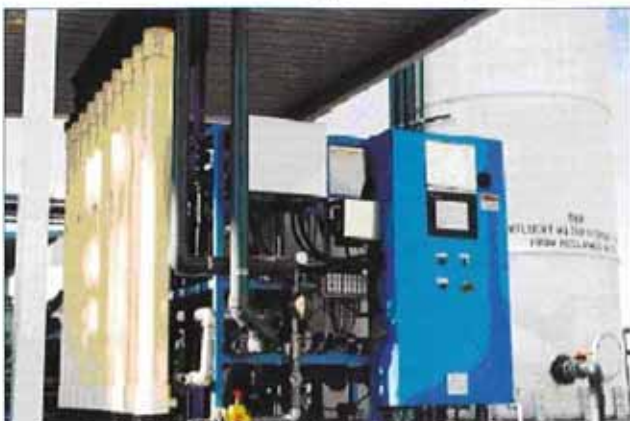
Pall ARIA-MF-yksikkö käänteisosmoosilaitteiston esisuodatukseen.
