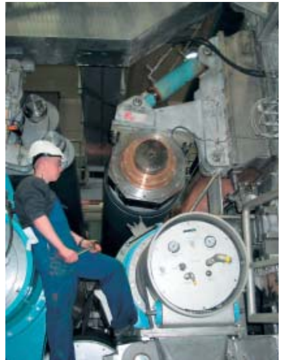
Inpro asennettuna telan laakerointiin Kaukas Oy:n tehtaalla Lappeenrannassa.
